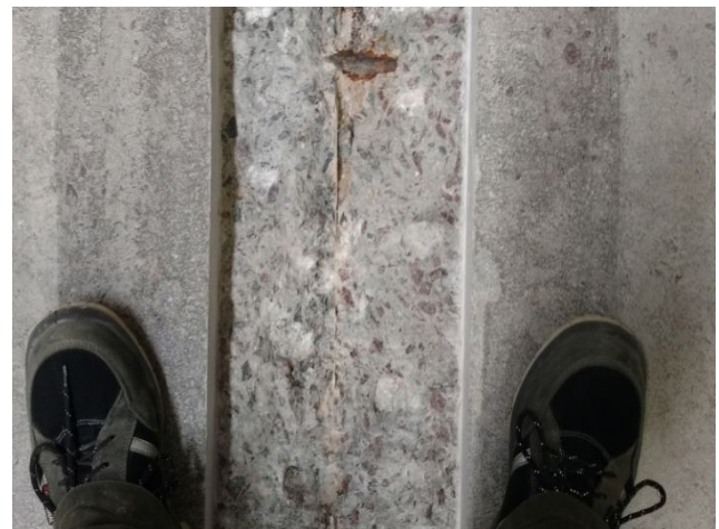
DETALLE DE CAJA DE JUNTA
