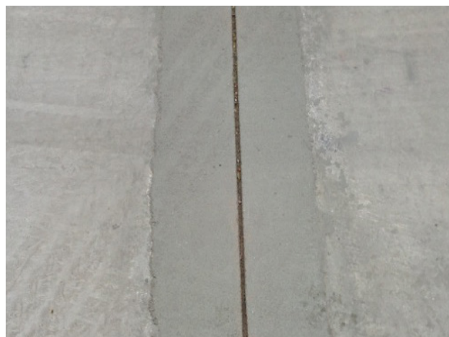
LABIOS DE JUNTA REPARADOS Y CORTE DE NUEVA JUNTA
