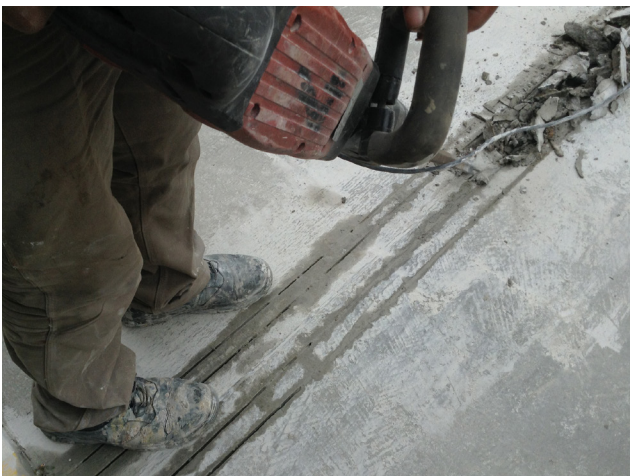
CORTE Y DEMOLICIÓN DE LA JUNTA DETERIORADA
