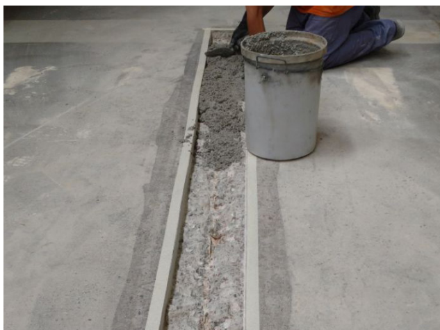
APLICACIÓN FERROPUR CR® CON LLANA
