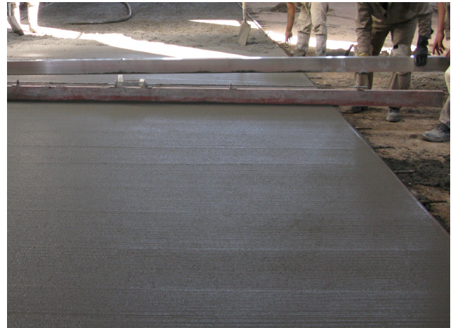
COLADO Y ENRASADO DE GROUTER N28F®
