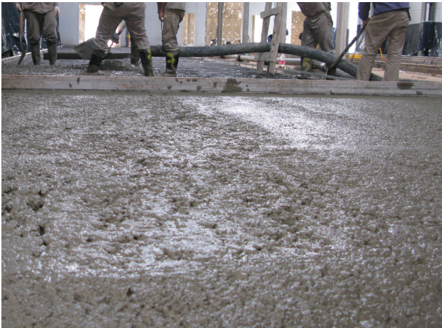
COLADO Y ENRASADO DEL HORMIGÓN
